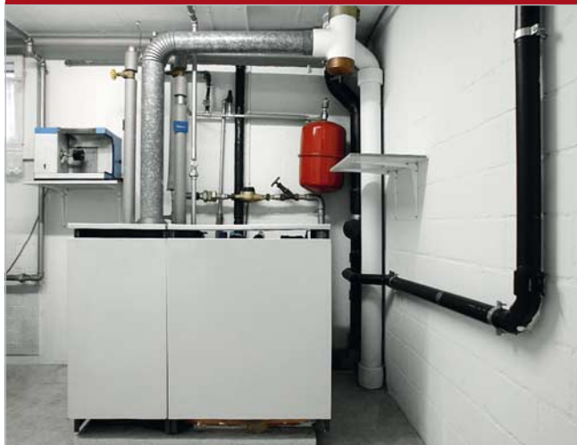
Der alte atmosphärische Gaskessel vor der Demontage.
